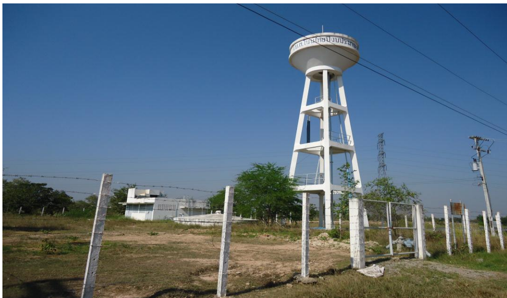
รูปที่ 2.2 ระบบประปาผิวดิน บ้านโนนหวาย หมู่ที่ 4
