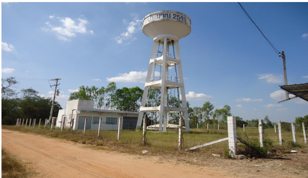
รูปที่ 2.4 ระบบประปาผิวดิน บ้านสระระเซ่ หมู่ที่ 13
